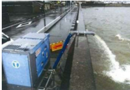
写真2-9-3 リースポンプによる排水状況 平成28年9月 台風16号
