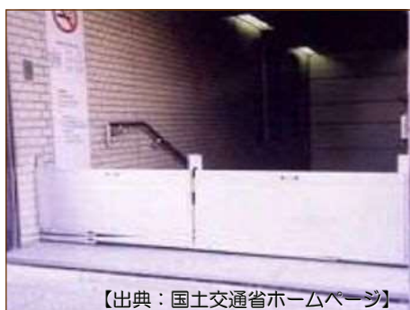
写真2-9-1 止水板の設置状況 (地下街入口)
