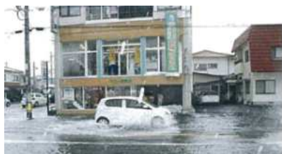
被害状況写真
