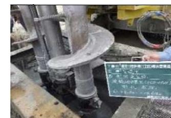
・セメントミルクを注入した穴に芯材となる鋼材をクレーンで下ろしていきます。
