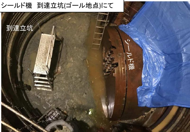
カッタヘッド(土を掘っていた箇所)が切斷され解体されます。
