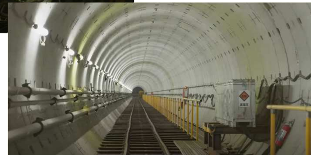
岡山市南部では、雨水管地下トンネルの築造工事が進行中。
