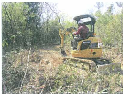
避難路の新設
