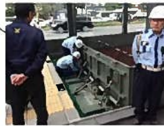
南端部の出入口は頑丈な起伏式を採用
