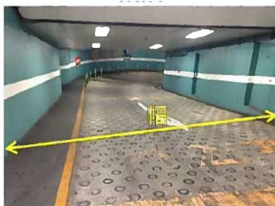
地下駐車場の出入口
