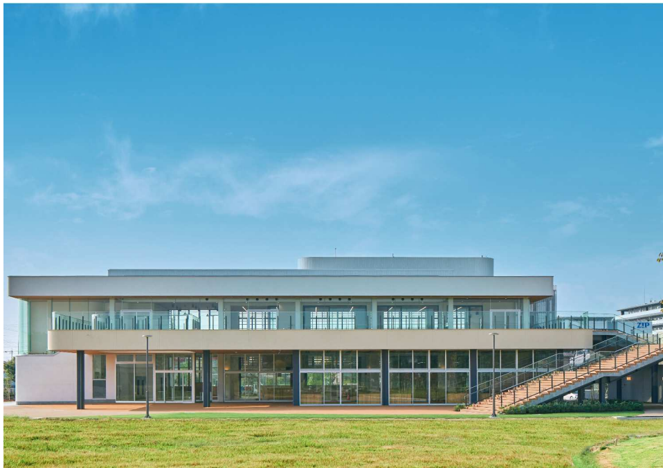
管理棟 北側外観 (昼)
