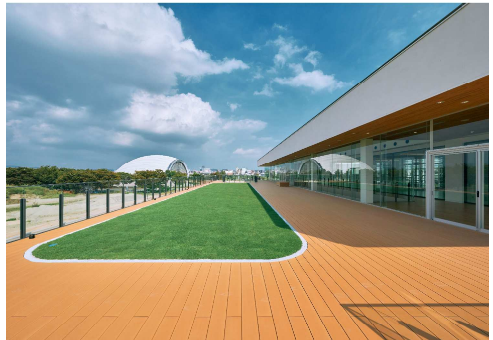
管理棟 2階 デッキ
