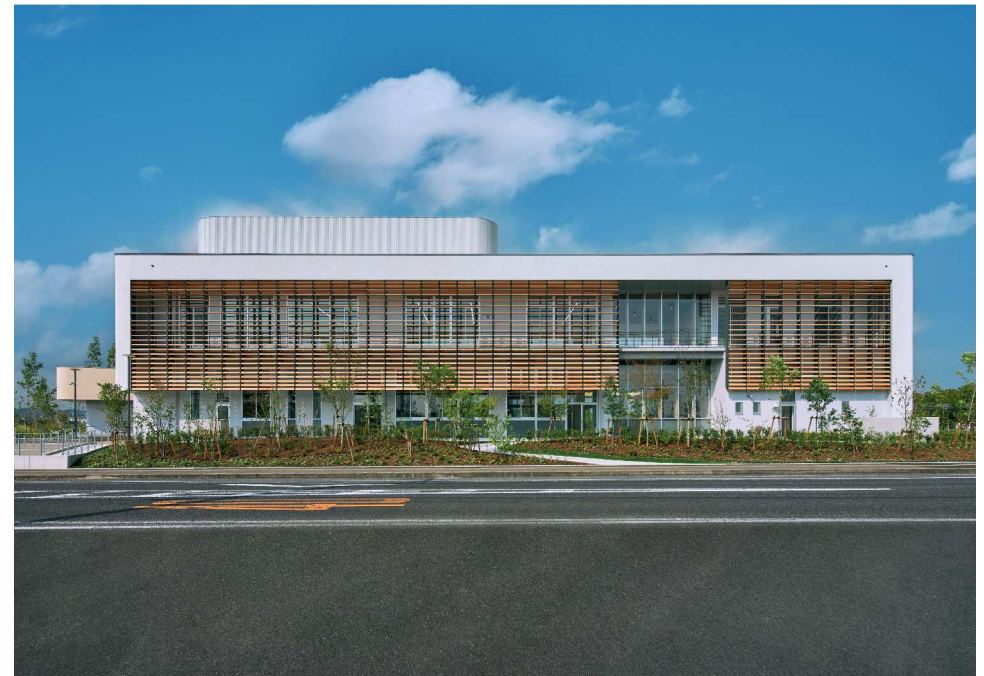
管理棟 南側外観 (昼)
