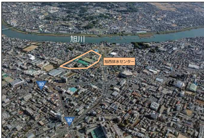
旭西排水センター位置 航空写真
