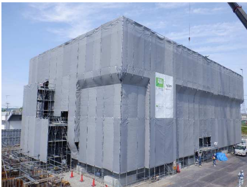
旭西排水センター新管理棟
