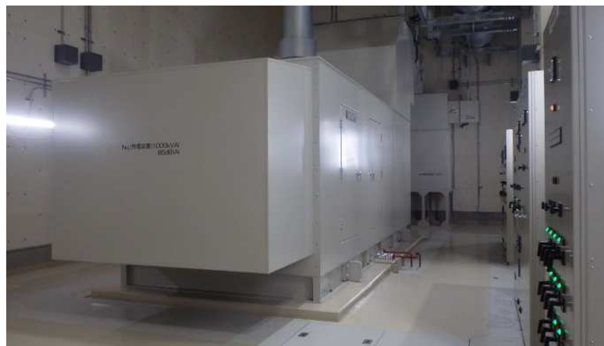
自家発電変電棟
