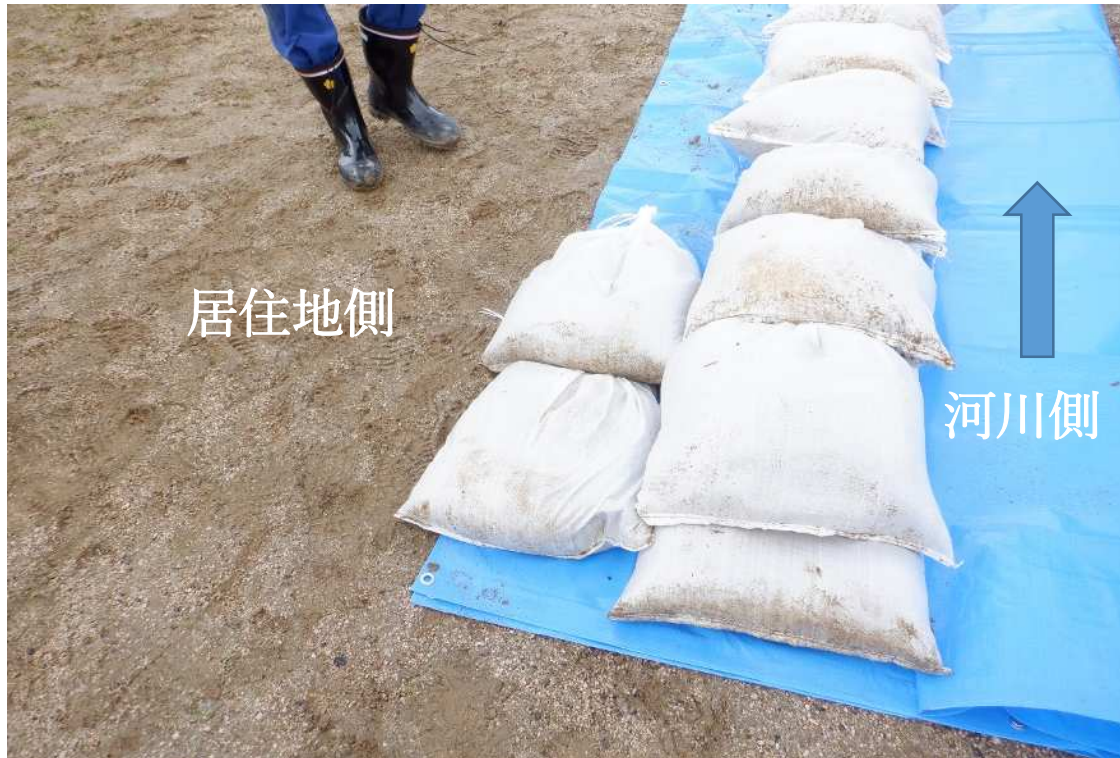
⑤居住地側に控え土のう1段目を積む。(河川側の土のうの間の位置に)
