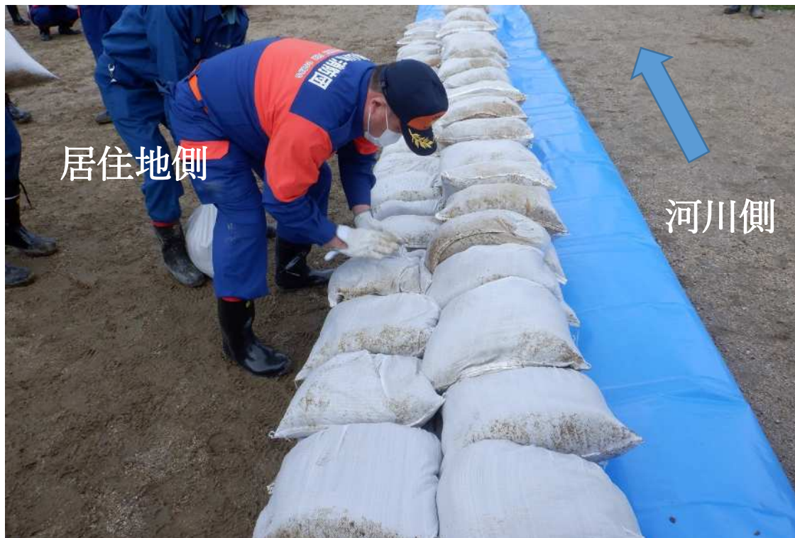
⑥同様に、河川側3段目、居住地側2段目を積む。
