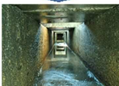
側溝や集水桝の土砂堆積
