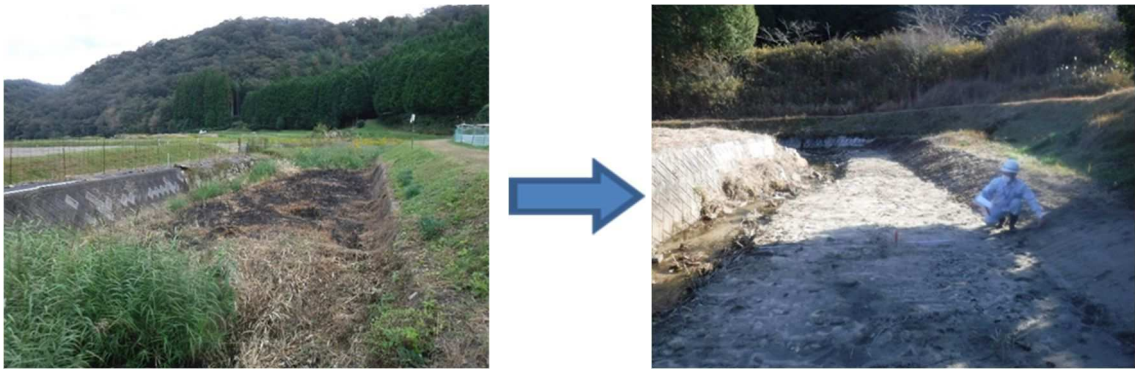
写真2-4-1 河道内の維持管理(掘削) イメージ
