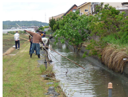
写真2-4-4 地域住民による浚渫状況
