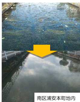
写真2-4-3 幹線水路の藻刈りの事例
