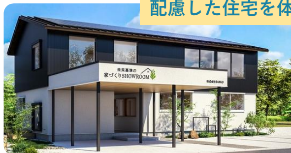
株式会社SANKO ZEH 岡山市中区東川原、 岡山市中区徳吉町
