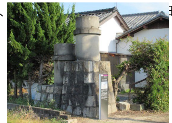
横樋の共同濾過槽
