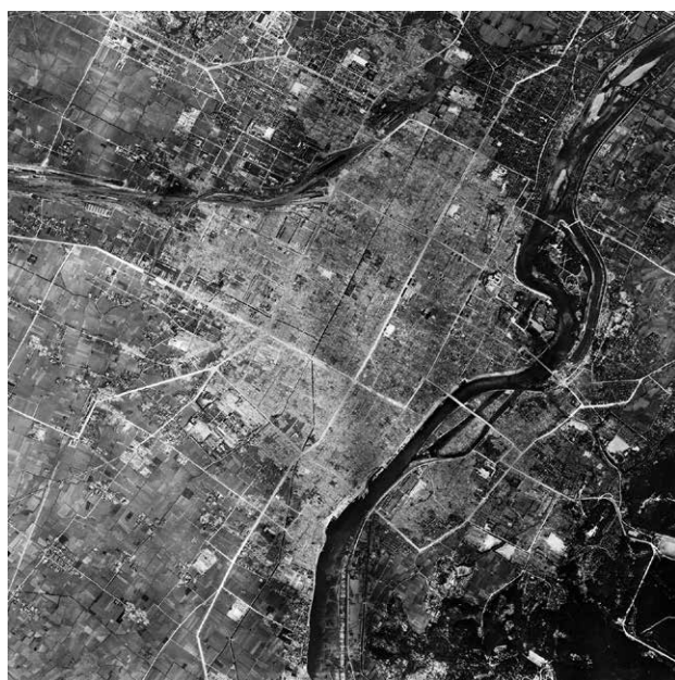
写真-2 空襲後の岡山市街地 1945年7月5日撮影。(米国立公文書館)
