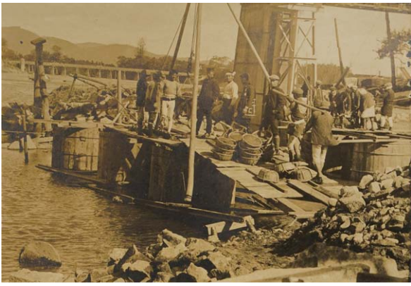
橋脚の基礎工事（コンクリートの注入）
