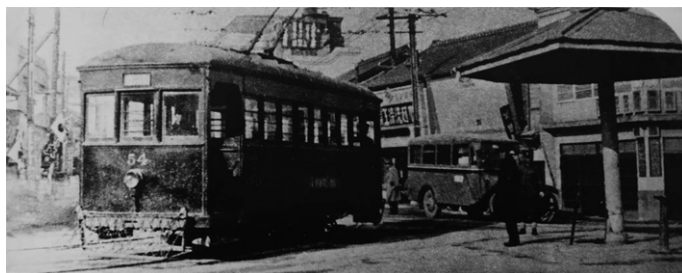
◎昭和初期の城下停留所（岡山電気軌道株式会社所蔵写真）
