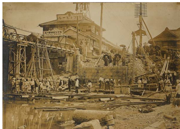
橋脚の基礎の杭打ち (次頁の京橋掛替工事のアルバムから)
