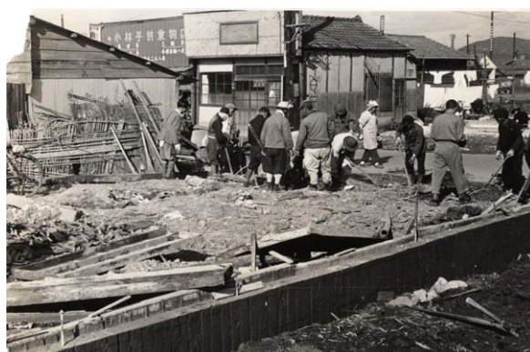
建物の撤去（富田町、上西川付近）
