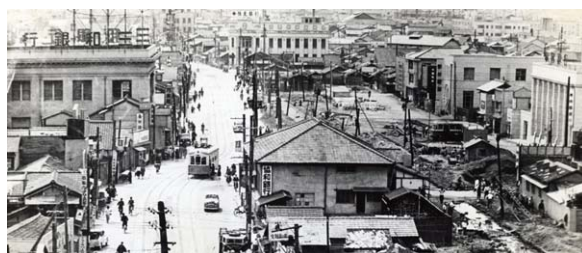
城下付近の工事 昭和28年（1953年）5月7日
