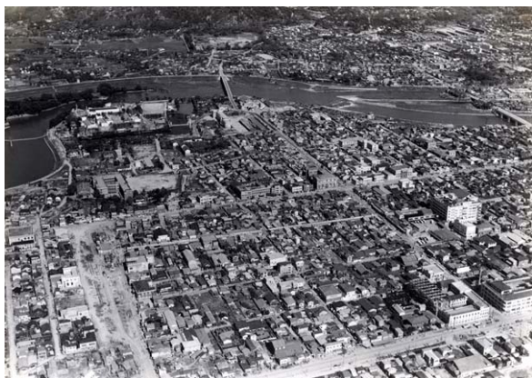
城下付近で工事が始まっている様子
