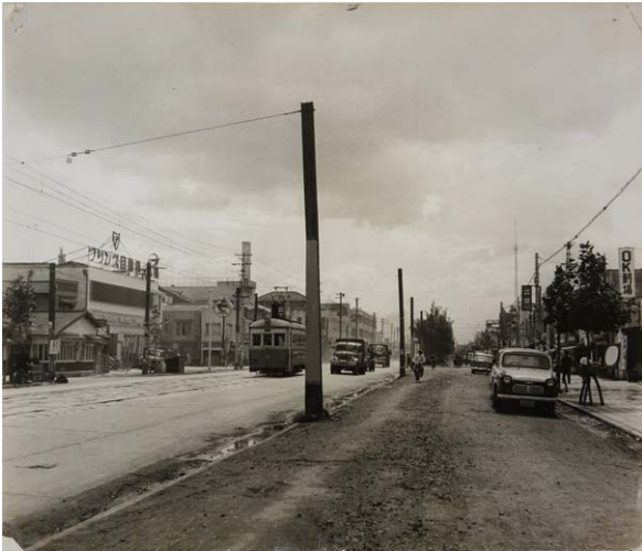
柳川筋の拡幅工事
