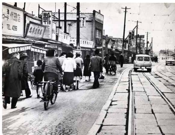
施工前の駅前城下間の道路 昭和31年（1956年3月12日）
