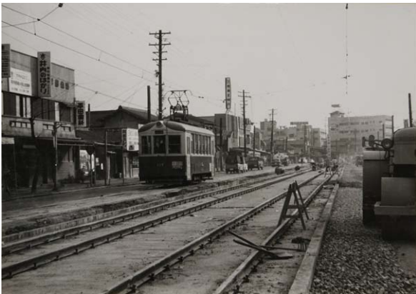
京町付近、市内電車の新しい軌道の敷設状況
