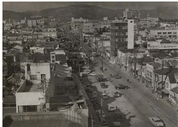
城下筋での建物の取り壊し
