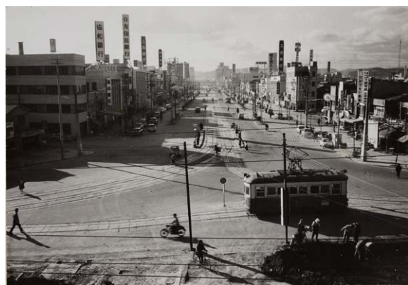
拡幅工事が終わった、城下交差点
