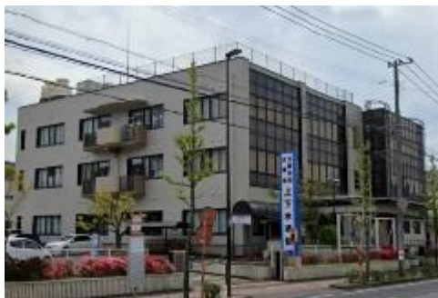
上下水道部合川庁舎 (築37・53年)
