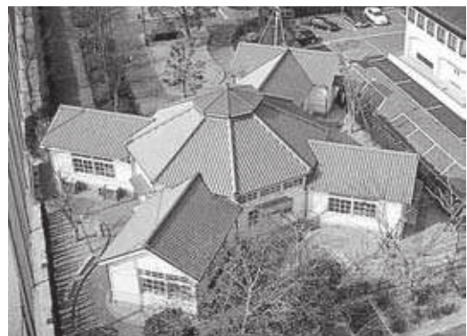
国指定重要文化財旧旭東幼稚園園舎
