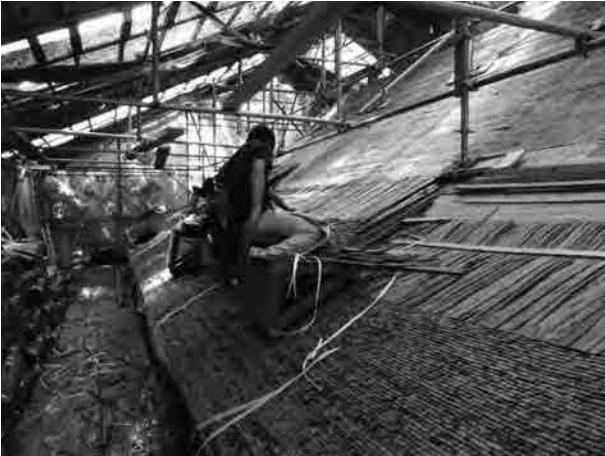
国指定重要文化財吉備津神社北随神門保存修理
