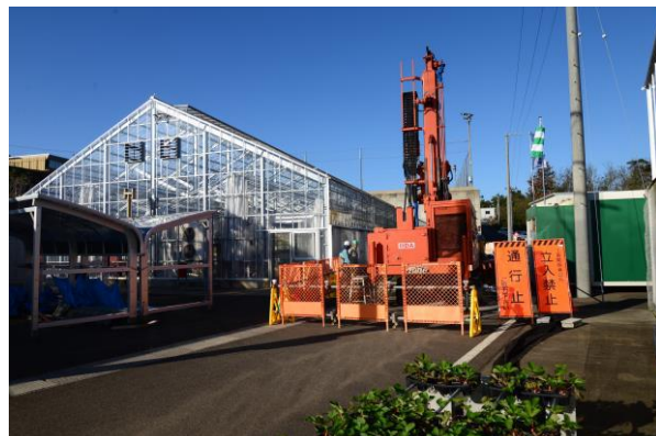
ボアホール掘削作業
