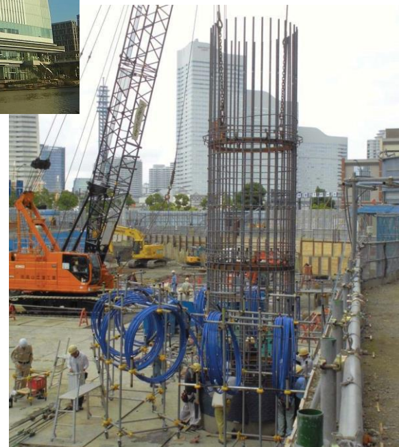
地中熱交換器設置の様子 (写真提供:横浜市)
