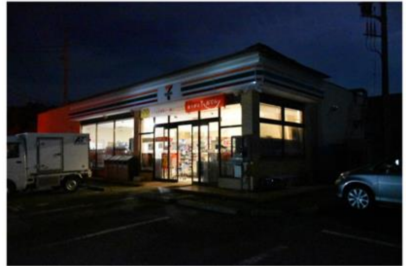
自家発電装置で24時間営業を続けるセブン-イレブン白浜港口店＝千葉県南房総市白浜町で2019年9月12日午後10時51分、秋丸生帆撮影
