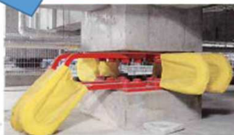
免震装置（鋼材ダンパー）
