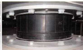
免震装置（積層ゴムアイソレーター）
