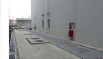
灯油地下タンク18,000ℓ（屋外）
