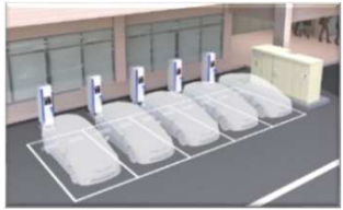
V2X (50 kW) EV車への急速充放電 (太陽光発電連携)
