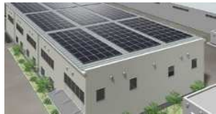
太陽光発電20kW(既設)
