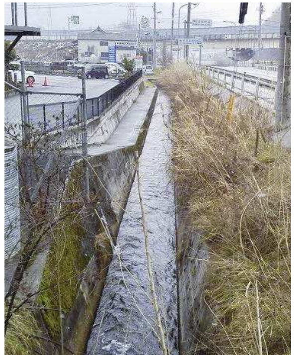
設置前の水路の様子
