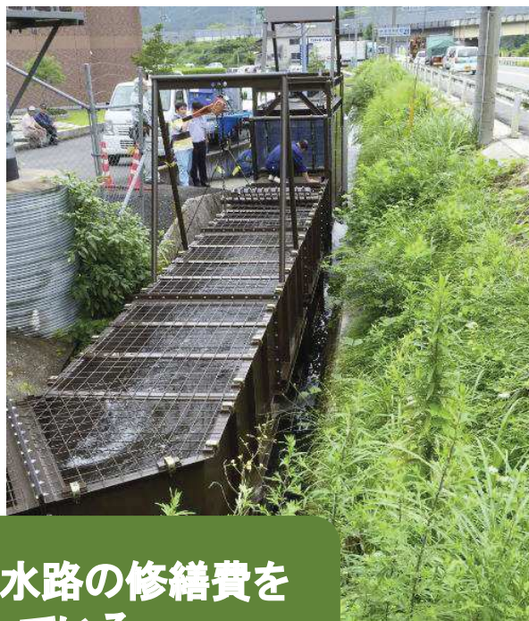
設置後の現況
