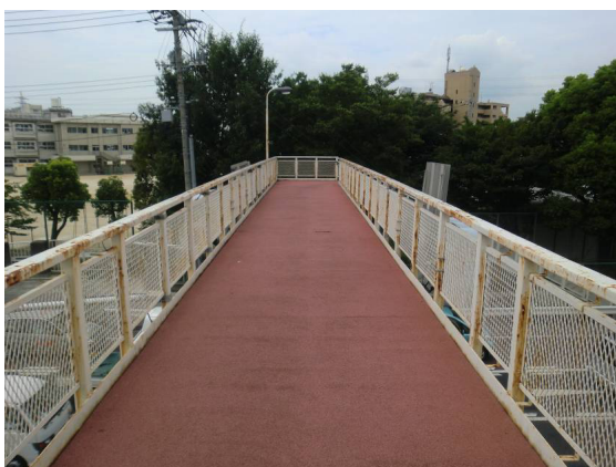
高欄の塗膜劣化, 腐食
