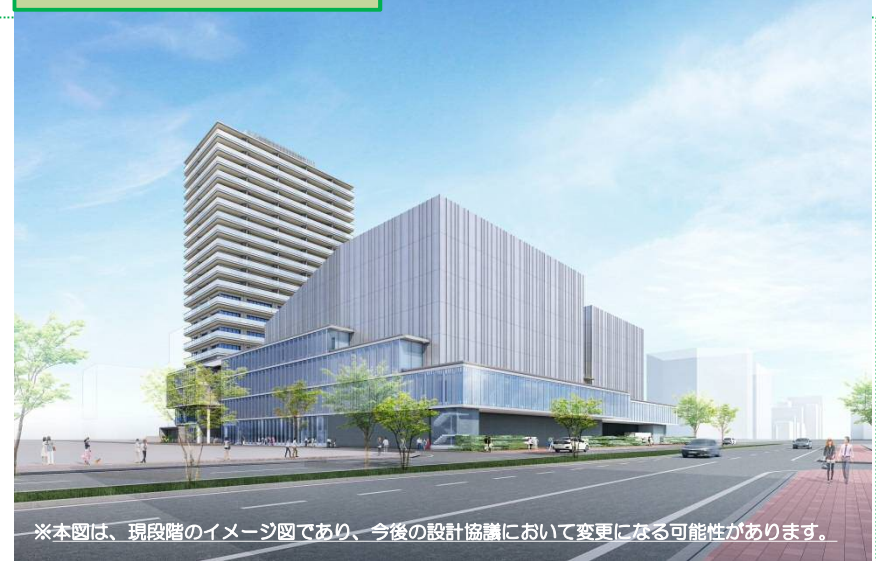
全景（南西方向から）
