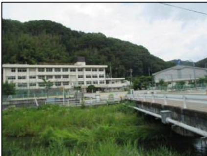
①高田小学校跡地 岡山市北区下高田2043-1ほか 8,988.10㎡
