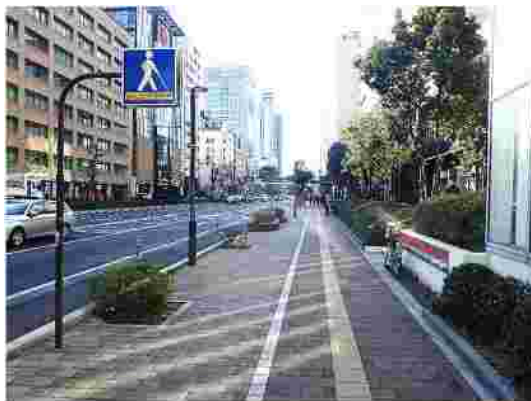
視覚障がい者誘導ブロックの設置
