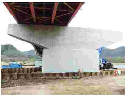
橋脚の補強による耐震化
