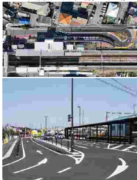
JR庭瀬駅北口広場整備[R6.3完成]
