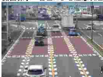
路面標示・着色による注意喚起
