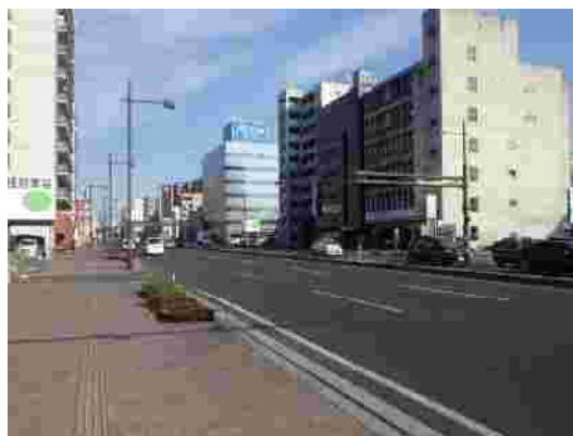
無電柱化による電柱の倒壊防止
