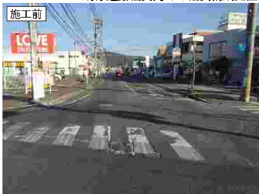
既存道路幅員内での幅員構成見直しによる渋滞対策（左折レーンの新設）
