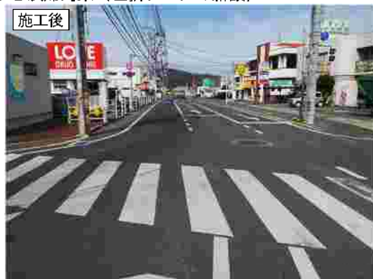
既存道路幅員内での幅員構成見直しによる渋滞対策（左折レーンの新設）
