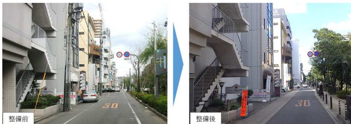
図 1-2 無電柱化前後の道路の風景（市道岩田町大学町線）
