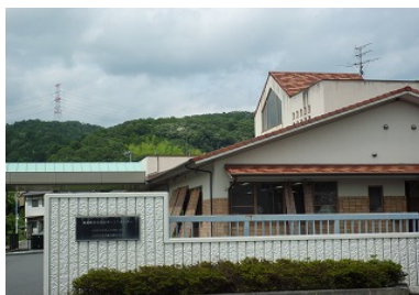
③建部町在宅福祉サービスセンター
