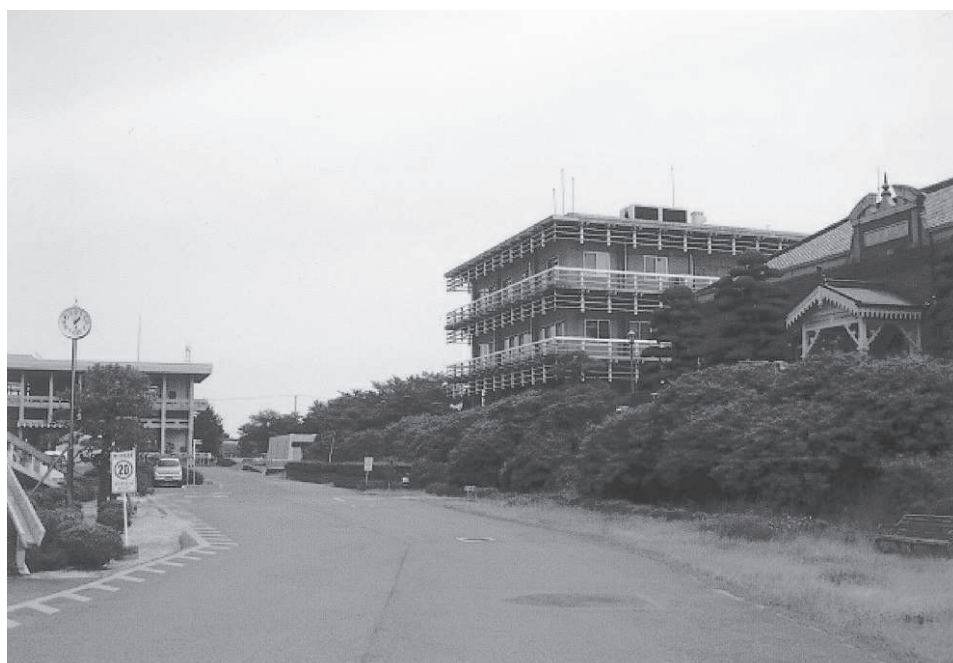
三野浄水場の建物写真
