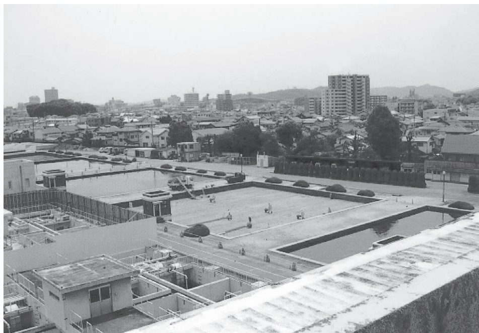
三野浄水場の施設の写真
