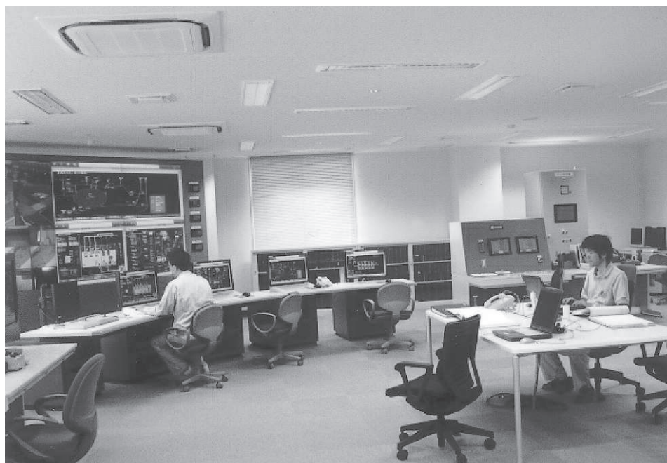
三野浄水場の集中管理室の写真
