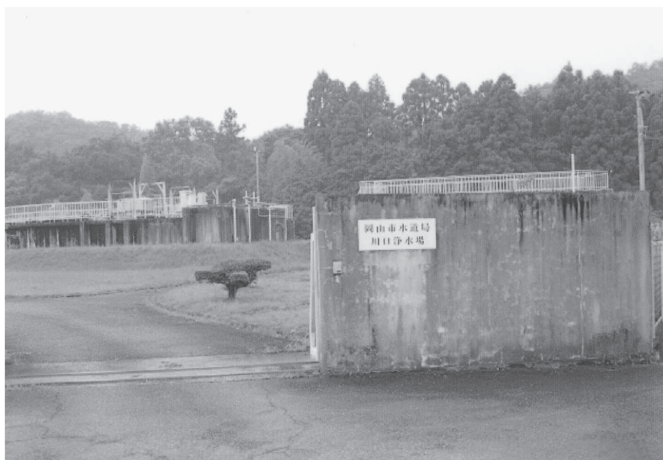
建部町川口浄水場の写真
