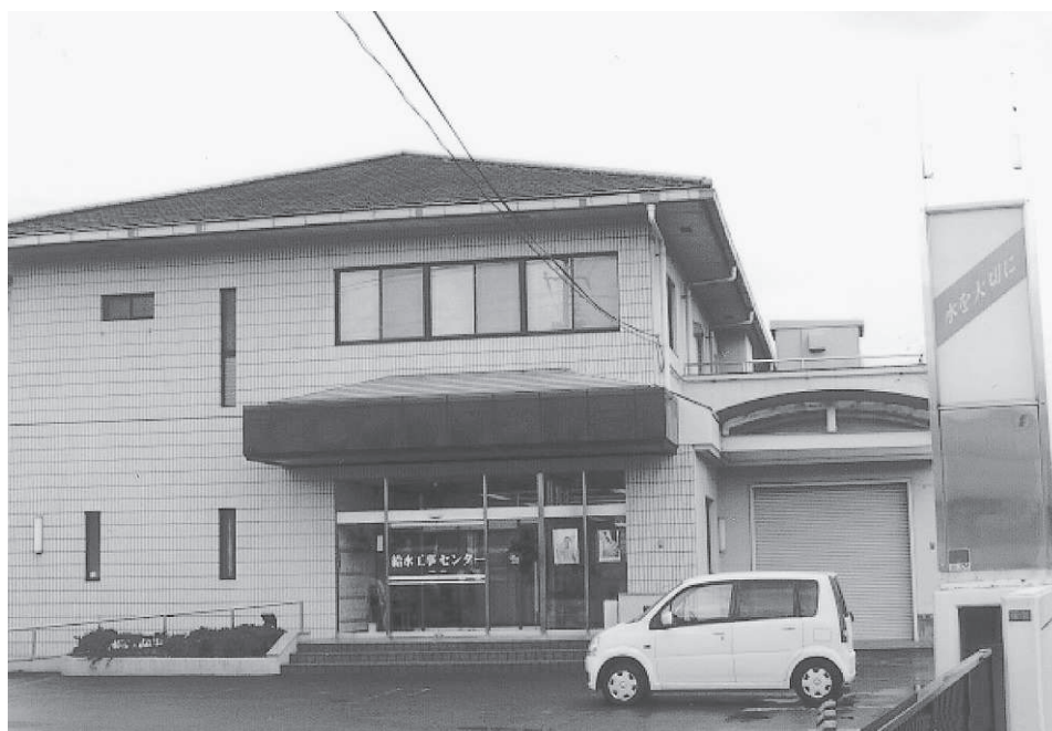
給水工事センターの写真
