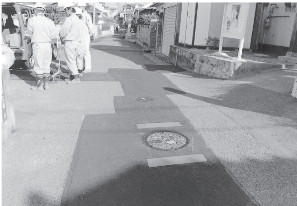
管工事の完成の検査状況の写真
