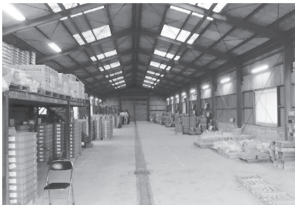
財団法人岡山水道サービス公社倉庫内の写真
