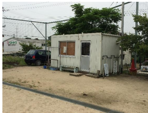
藤田都スポーツ広場（プレハブに電気が引かれている。）
