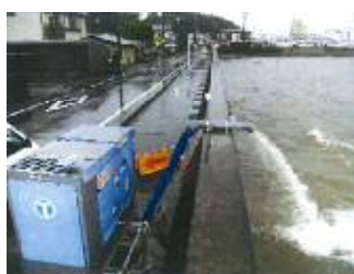
写真2-8 リースポンプによる排水状況 平成28年9月 台風16号
