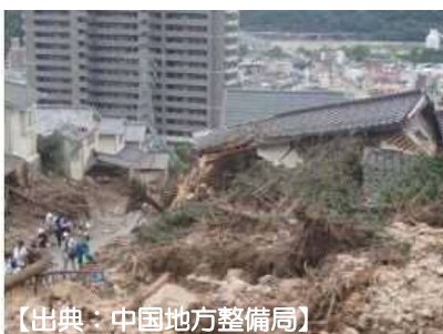
写真1-1 平成26年8月 広島土砂災害
