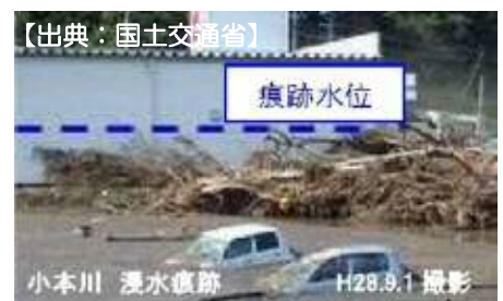
写真1-3 平成28年8月 岩手県小本川氾濫被害
