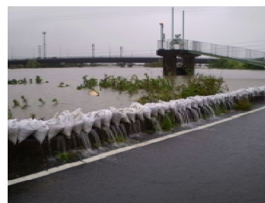
写真2-7 平成23年台風12号による 笹ヶ瀬川越水状況
