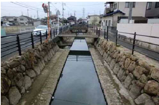
写真2-2 倉安川整備状況
