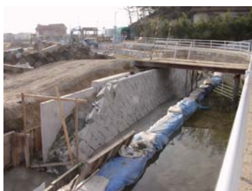
アユモドキの 保全に配慮した 水路改修工事
