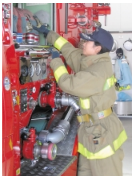
ポンプ車の点検の様子
