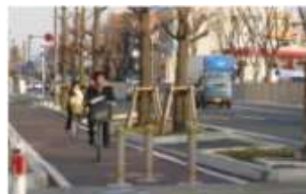
走行空間上の工作物が通行の支障となっている
