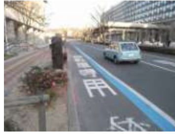
自転車専用通行帯 (自転車レーン) (県庁通り)
