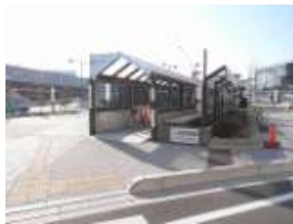
岡山駅西口地下自転車駐車場
