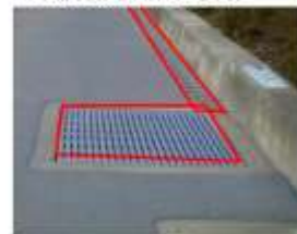
グレーチング間の格子間隔を狭め、滑り止め加工している事例
