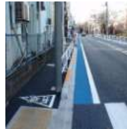
グレーチング間の格子間隔を狭め、滑り止め加工している事例
