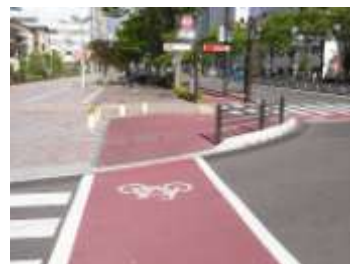
自転車の滞留空間を確保した例（仙台市）
