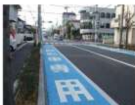
街渠をエプロン幅の狭い特殊側溝に置き換えた事例
