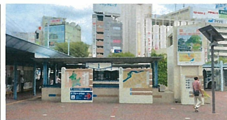
現在の地下街との連絡階段
