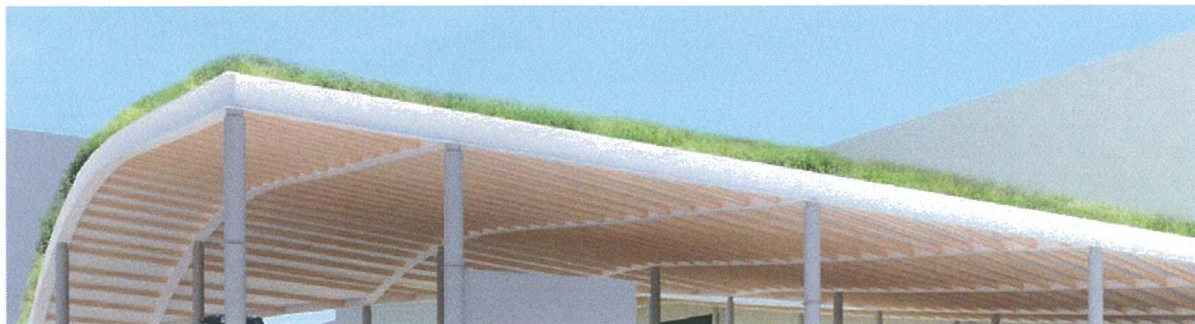
緑の屋根は、鉄骨を主構造とし、岡山県産の木材を緑化屋根の下地とすることで、自然環境との共生のシンボルとする
