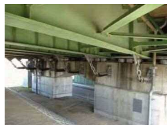
■ 落橋防止対策
