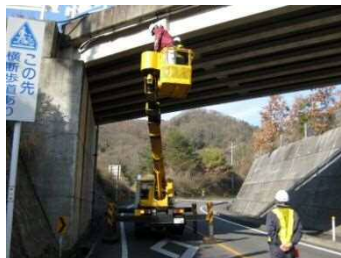
■ 橋梁の点検作業
