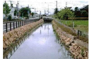
■ 倉安川の改修
