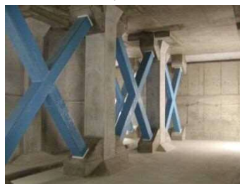
■耐震補強された 矢坂山配水場 2号配水池
