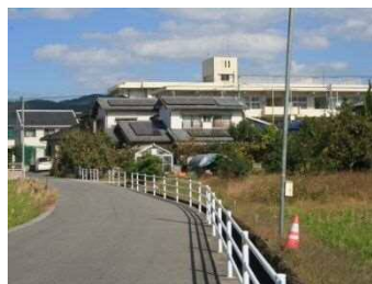
■ 転落防止柵の設置
