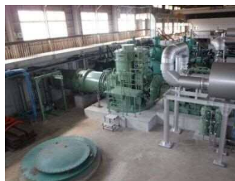
■雨水排水ポンプの新設（笹ヶ瀬）
