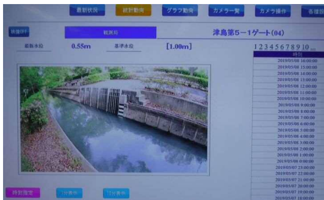
ゲートの監視カメラ表示画面
