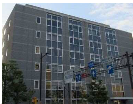
分庁舎4階 (下水道河川局)
