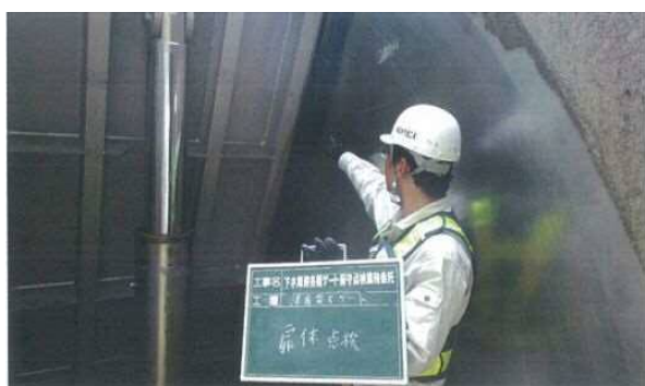
保守点検実施状況 (津島第5ゲート)
