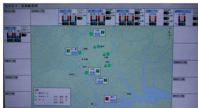
ゲートやポンプ施設の配置及び稼働状況の表示画面
