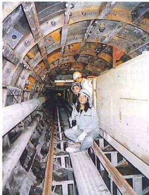
下水設備の概要の説明を受けた後、下水管工事現場を見学(写真一番手前)
