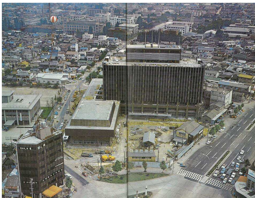
《昭和 43 年に現本庁舎整備》
