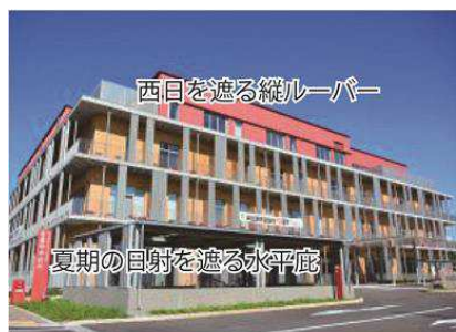
水平庇と縦ルーバー／安曇野市
