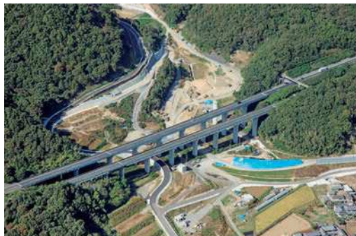
美作岡山道路瀬戸インターチェンジ（建設中）
