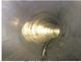
雨水管築造工事
