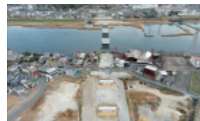
(都) 下中野平井線 (旭川橋梁部)
