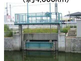
樋門 (約4,000箇所(幹線))
